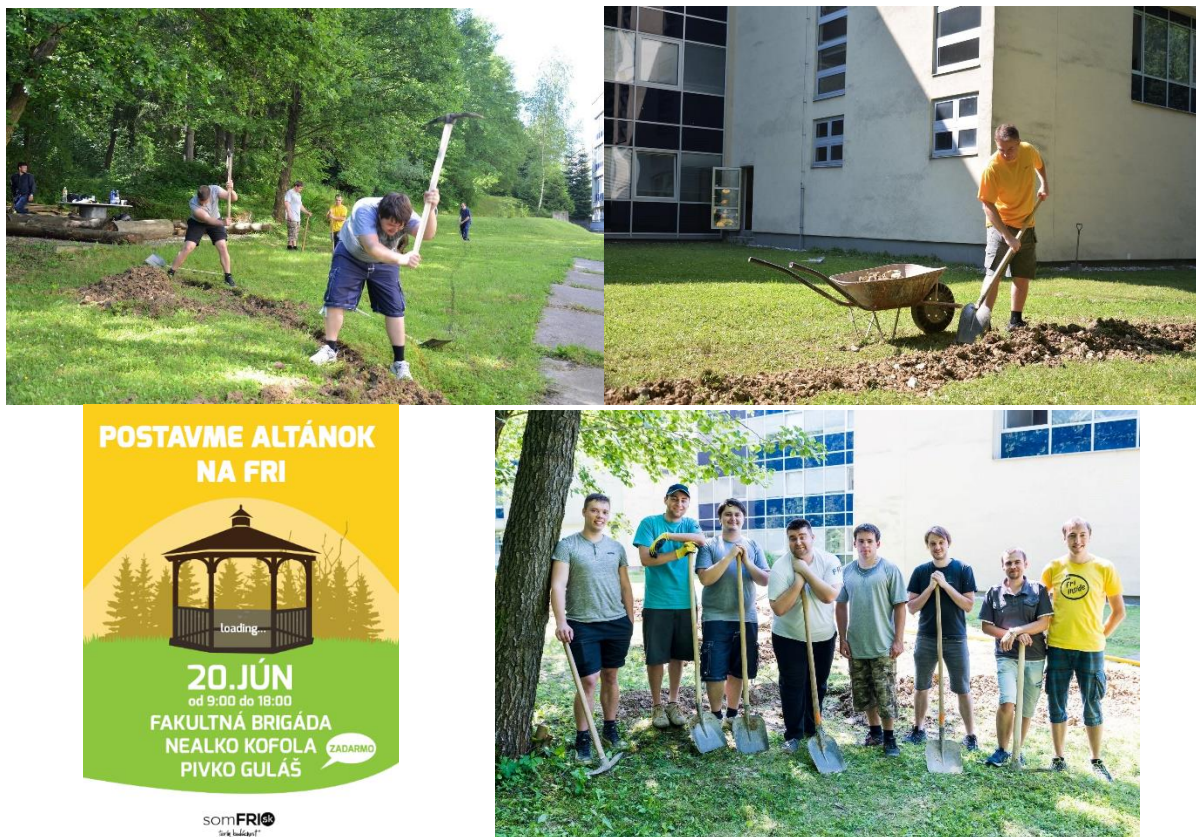
Obr. 23 Výstavba altánku FRI – I. etapa
