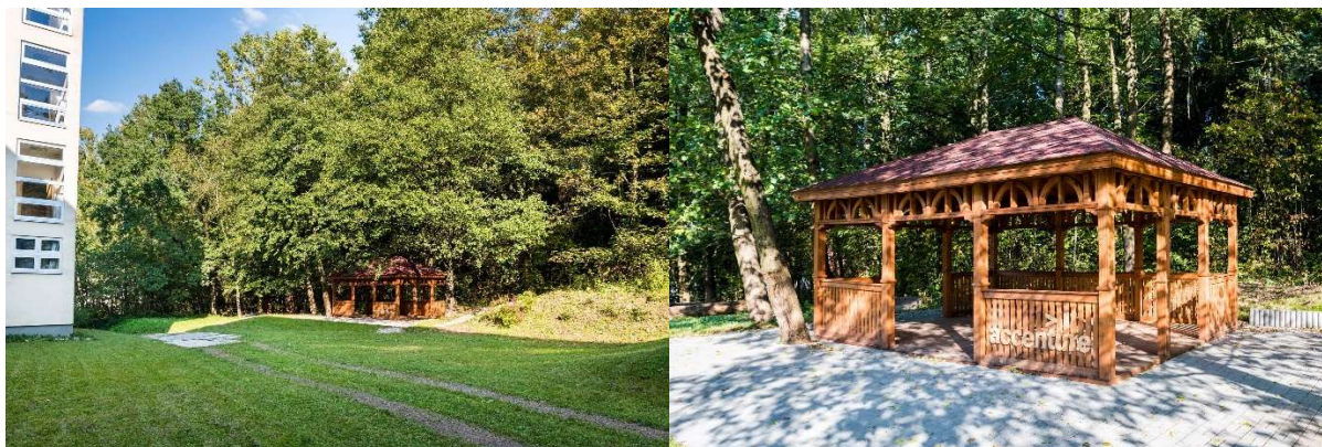
Obr. 86 Položenie zámkovej dlažby okolo altánku FRI
